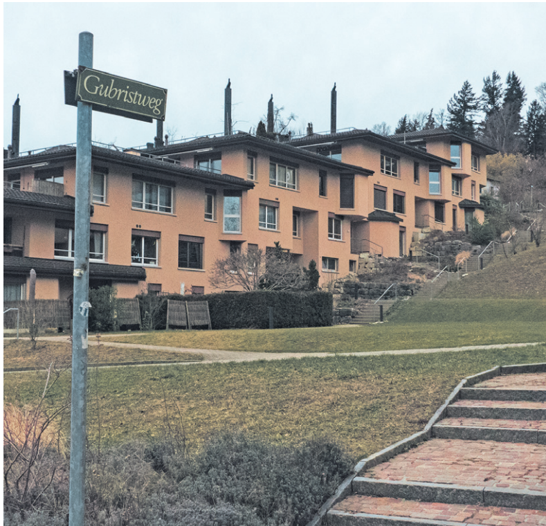
In den Hang gebaute Maisonettewohnungen mit grosszügigen Terrassen: die Siedlung der LBG im Rütihof.
